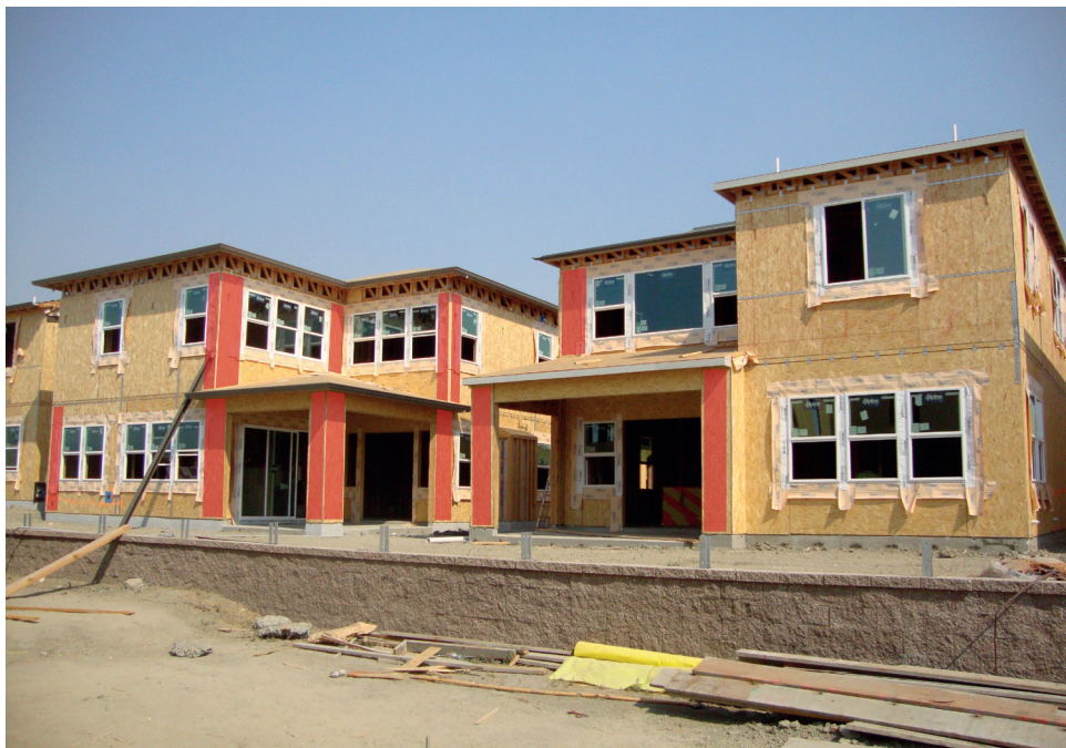
Zdj.2.7 Ściany usztywniające osłabione otworami. Zaznaczono fragmenty ścian zbyt krótkie, aby mogły pełnić funkcję usztywniającą.
