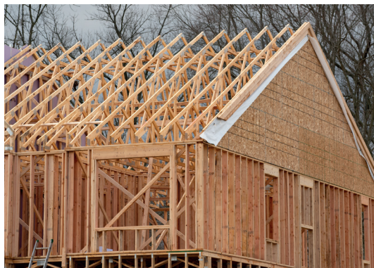
Zdj.9.4 Ściana szczytowa w technologii szkieletu drewnianego
