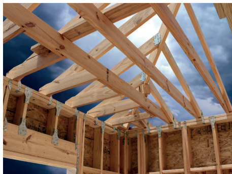
Zdj.5.2 Połączenia zapewniające integralność pojedynczej kondygnacji.
