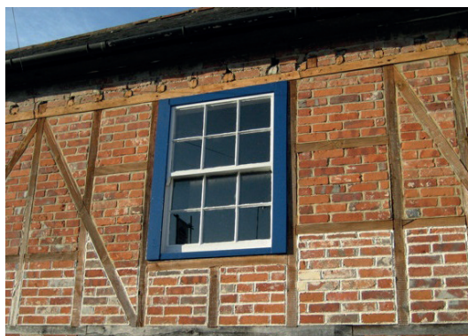
Zdj. 2.3 Usztywnienie zastrzałami na przykładzie muru pruskiego. (Zdj. Wikipedia.org)
