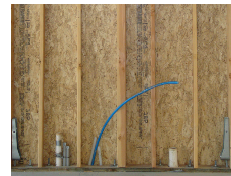
Zdj. 2.5 Zakotwienie ściany usztywniającej do fundamentu.
