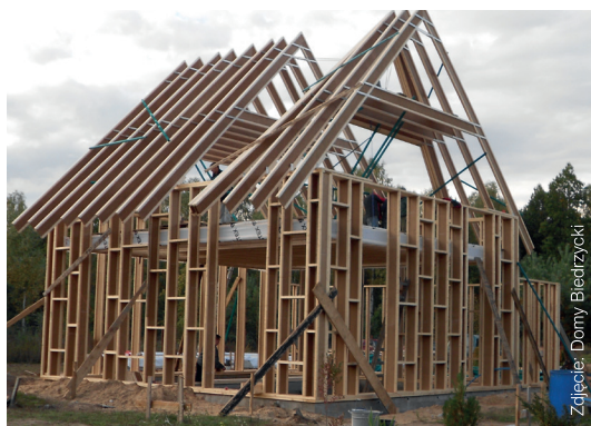
Zdj.10.8 Budynek szkieletowy o konstrukcji balonowej
