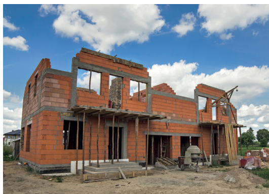
Zdj.9.5 Murowane ściany wzmacniane trzpieniami żelbetowymi
