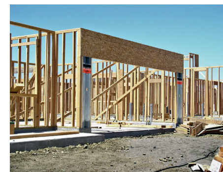
Zdj. 2.9 Rama usztywniająca Steel Strong-Portal.
