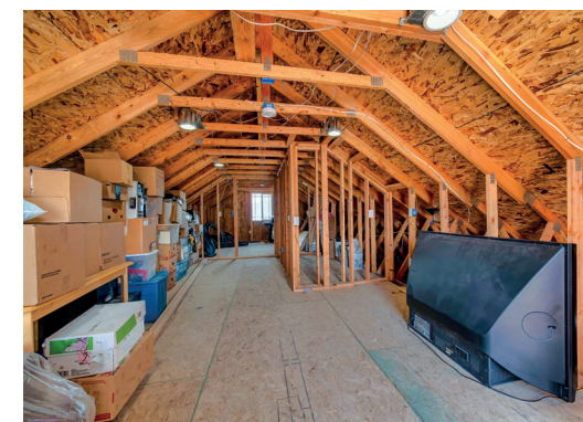
Zdj.9.3 Konstrukcja poddasza wykonana przy użyciu wiązarów attykowych
