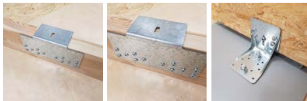
Zdj.3.7 Sekwencje montażu kątownika dwuczęściowego SC2P.
