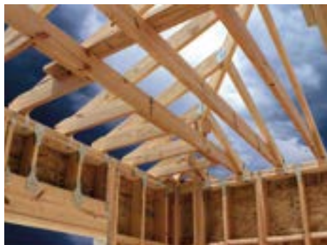
Zdj.5.2 Połączenia zapewniające integralność pojedynczej kondygnacji.
