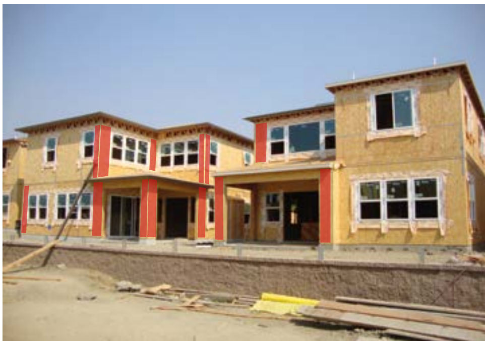
Zdj.2.7 Ściany usztywniające osłabione otworami. Zaznaczono fragmenty ścian zbyt krótkie, aby mogły pełnić funkcje usztywniającą.
