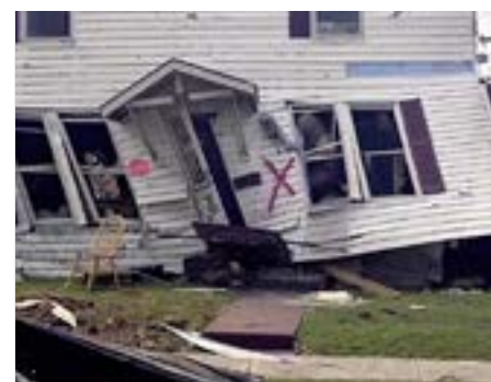
Zdj. 2.1a Zniszczenie domu na skutek utraty sztywności.
