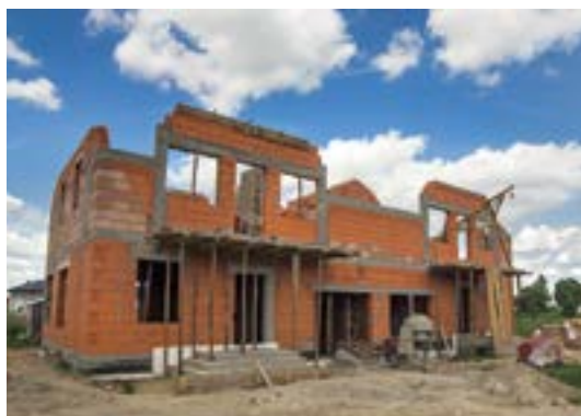
Zdj.9.5 Murowane ściany wzmocnione trzpieniami żelbetowymi
