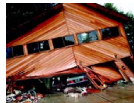
Zdj. 2.1b Zniszczenie domu na skutek utraty sztywności
