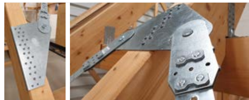
Zdj.11.6 Blachy węzłowe pojedyncza – (BNF) i podwójna (BNK) połączone z taśmą adapterami (BNKK).
