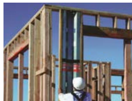
Zdj. 2.8 Steel Strong-Wall stalowy profil usztywniający.
