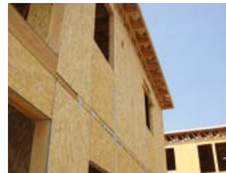
Zdj. 2.4 Domy drewniane usztywnione poszyciem OSB.
