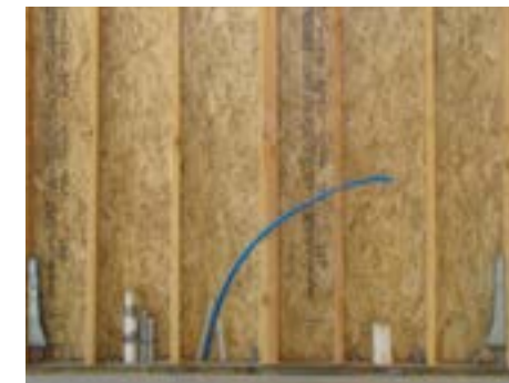
Zdj. 2.5 Zakotwienie ściany usztywniającej do fundamentu.
