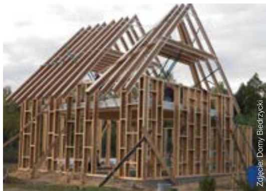
Zdj.10.8 Budynek szkieletowy o konstrukcji balonowej
