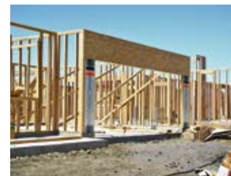
Zdj. 2.9 Rama usztywniająca Steel Strong-Portal.
