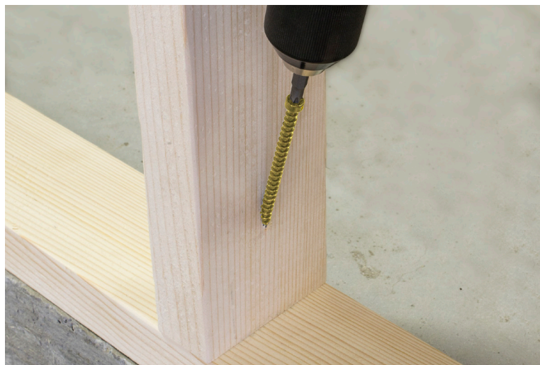
Wkręty ESCRFTZ połączenie wzmocniające ściany szkieletowej
