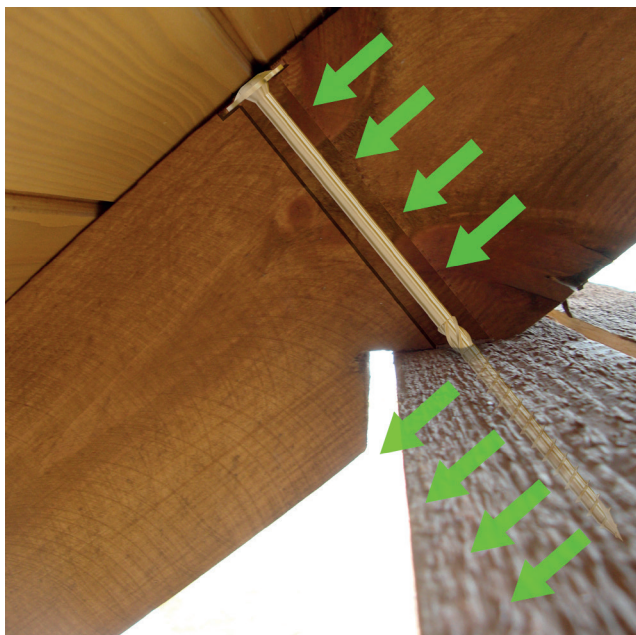
Zdj. 2. Rozwarstwienie w skutek przekazywania siły z krokwi na murlatę przez wkret ciesielski
