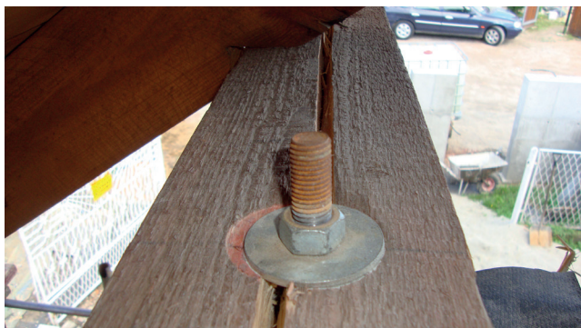
Zdj. 3. Rozwarstwienie przez stosowanie wkretów ciesielskich i rozciąganie w poprzek włókien
