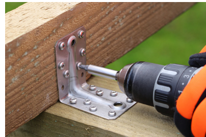
Połączenie kątownika ABR7015S (A4) wkrętem CSA-S (A4)
