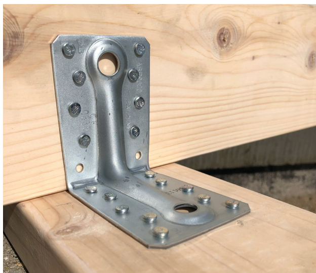
Złącze kątowe wzmocnione ABR9020 zamocowane za pomocą gwoździ systemowych CNA4.0X50 .
