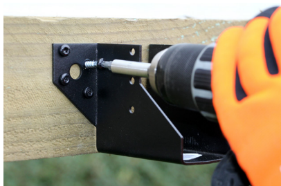
Czarny wieszak belki SAE-PB mocowany za pomocą wkrętów CSA-PB
